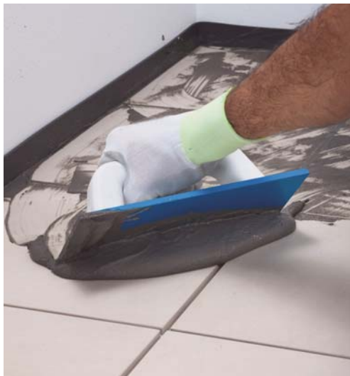
Stuccare la superficie del locale
