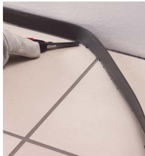
Ad indurimento della stuccatura, rifilare il bordo perimetrale tagliando la parte eccedente di Mapesonic Strip
