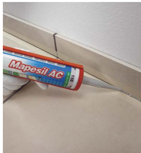
Sigillare lo spazio ricavato tra zoccolatura e pavimento con un idoneo sigillante elastico della gamma Mapei
