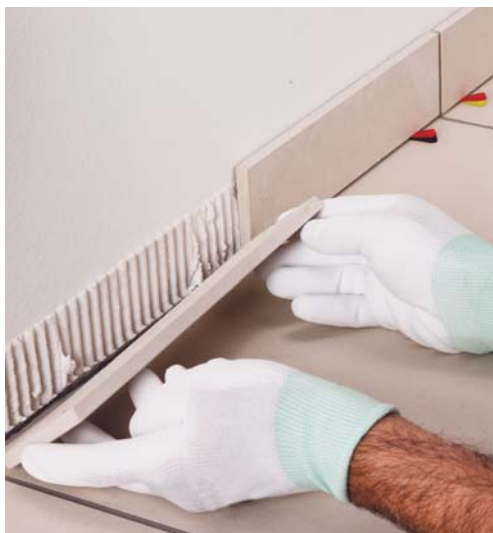
Applicare la zoccolatura perimetrale facendo in modo che non vi sia diretto contatto con la pavimentazione
