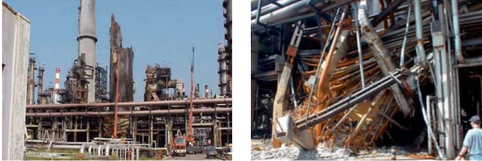
Figura 10.2. Terremoto di KOCAELI – Agosto 1999 – Raffineria Tupras di Izmit – Crollo ciminiera (115 m) forno Topping
