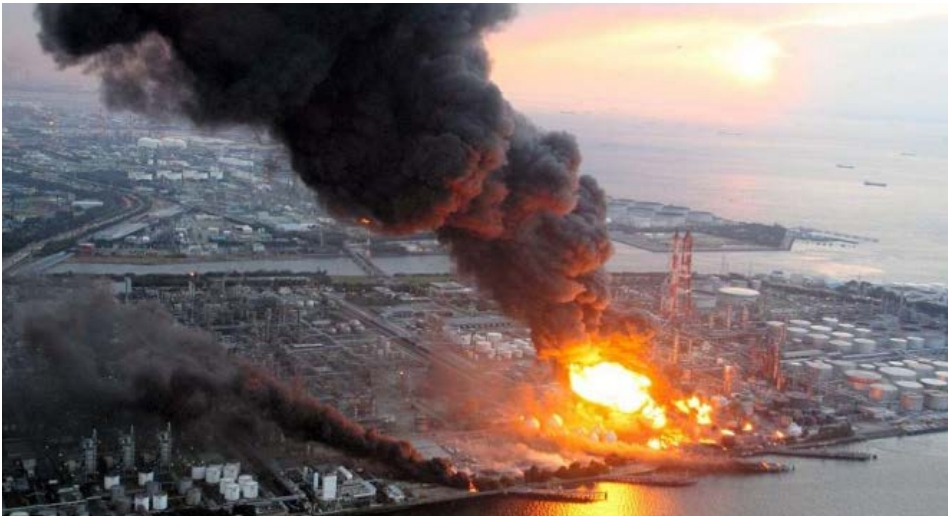
Figura 10.1. Terremoto di SENDAI marzo 2011 – Raffineria di Chiba della Cosmo Oil – Collasso sfera di stoccaggio prodotti petroliferi
