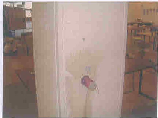
Prelievo di un campione di calcestruzzo dal pilastro della zona commerciale
