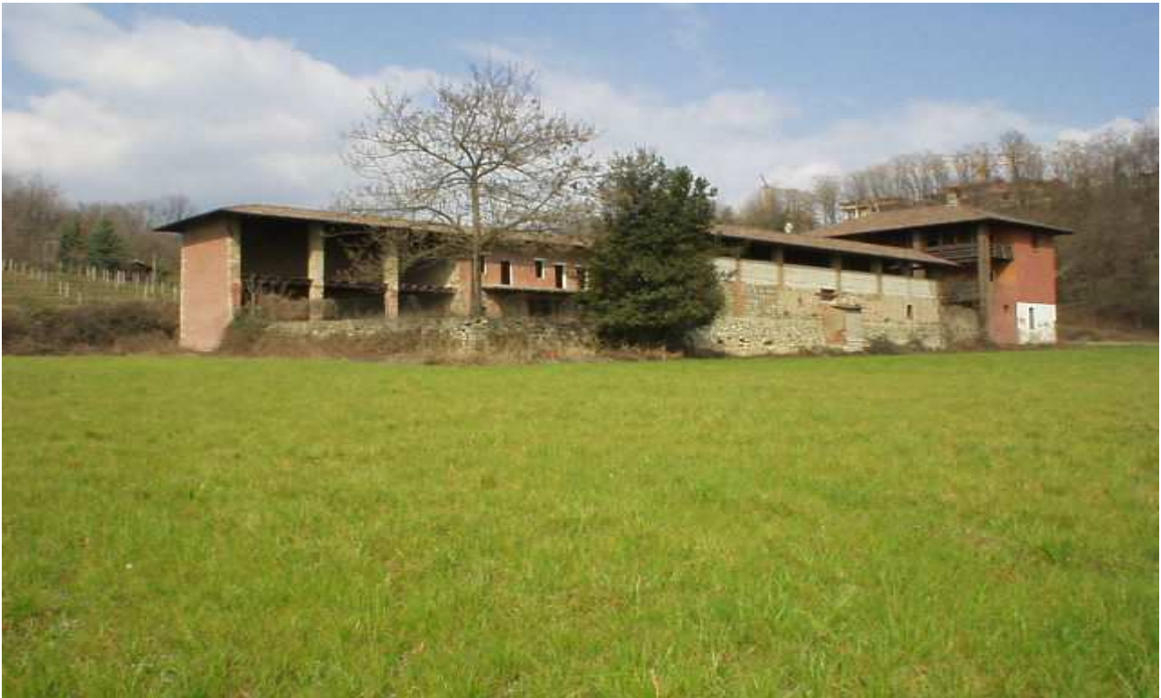
Vista dell'area interessata dall'intervento, Cascina San Giuliano Medolago (Bg)
