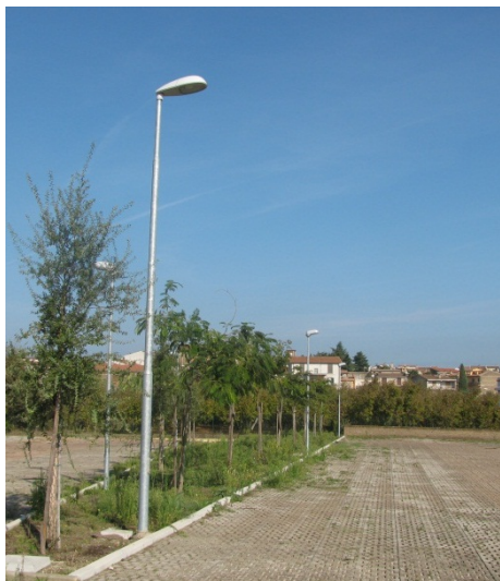
Figura 6.19 - testapalo, ottica con vetro piano vetro piano
