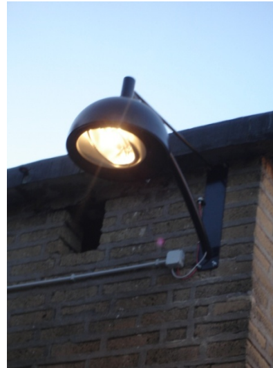
Figura 6.24- sbraccio a muro con armatura cut off
