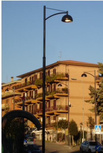
Figura 6.23 - palo con sbraccio ed armatura cut off
