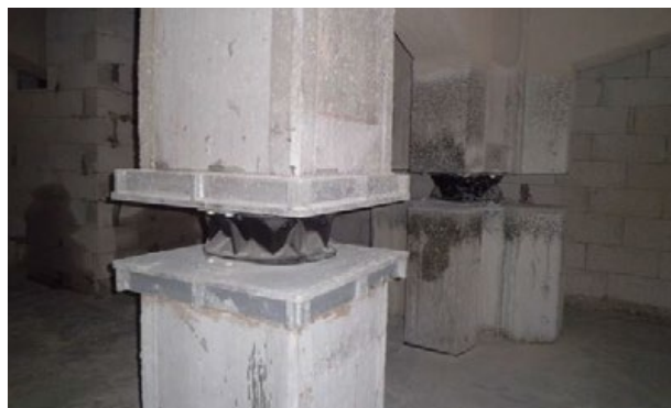
Figura 1: inserimento di isolatori e dissipatori
