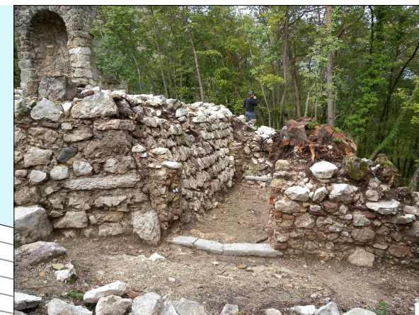
Settore C prima dell'intervento.
