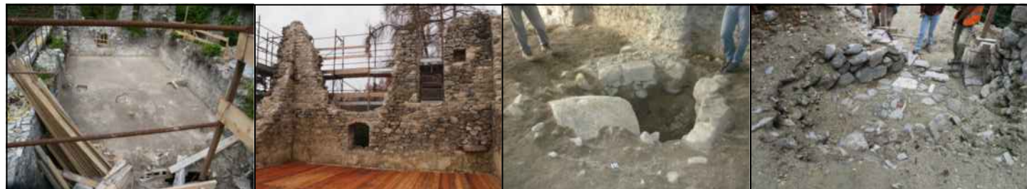
Fotografie durante l'esecuzione dei lavori
