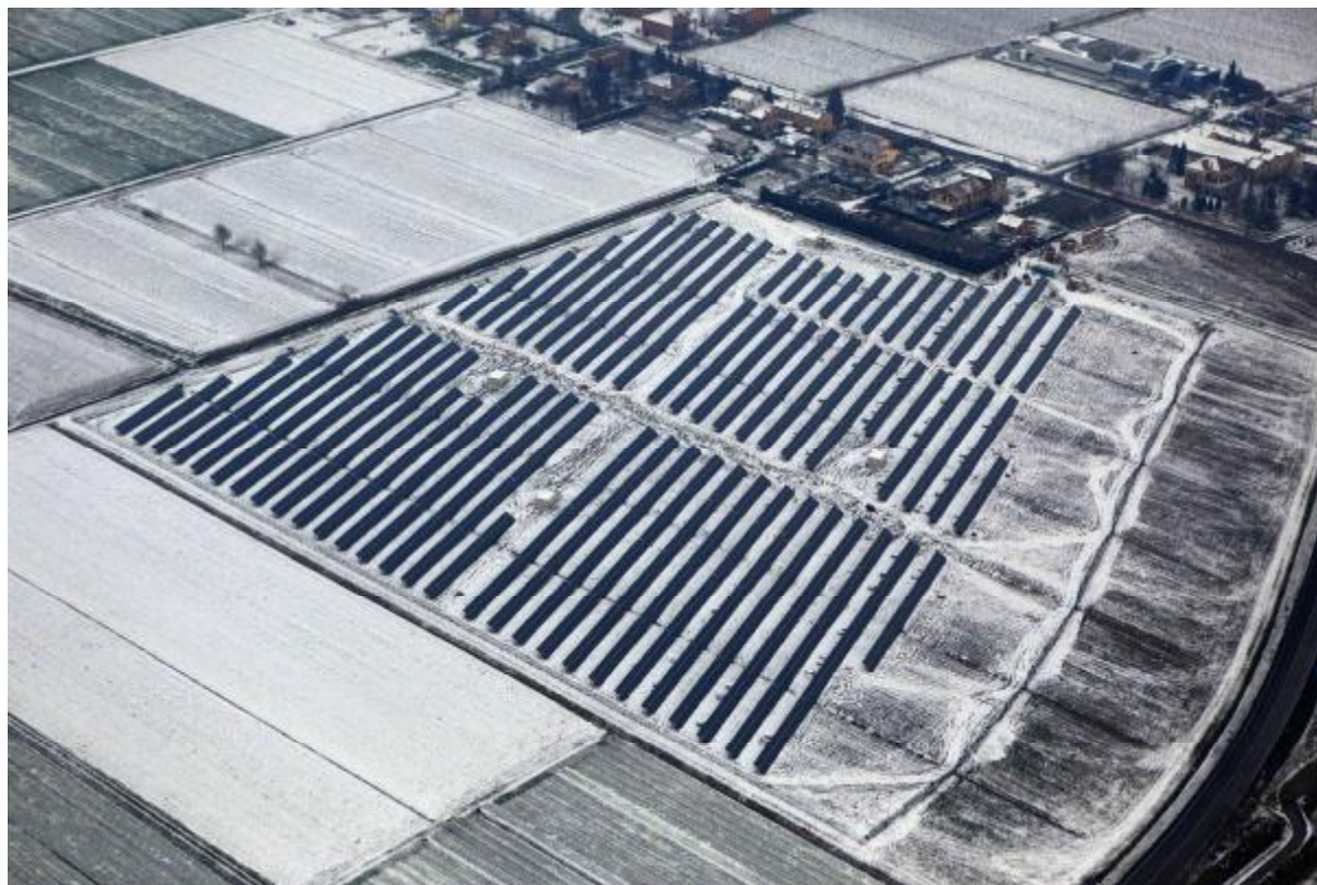
Campo a terra 2 Mw
