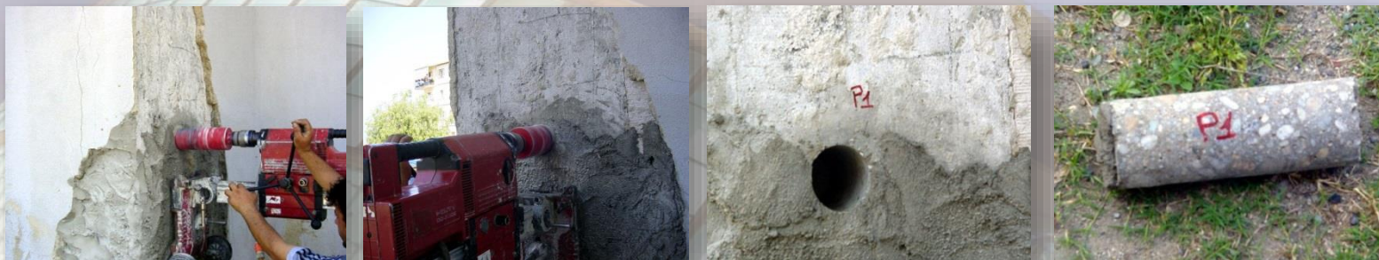
Estrazione di carote di calcestruzzo
