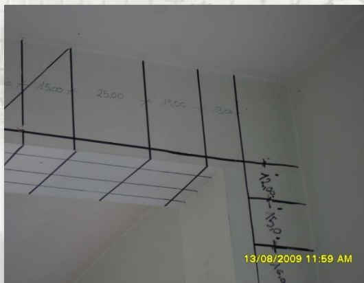
INDAGINE MAGNETOMETRICA – RILIEVO BARRE D'ARMATURA
