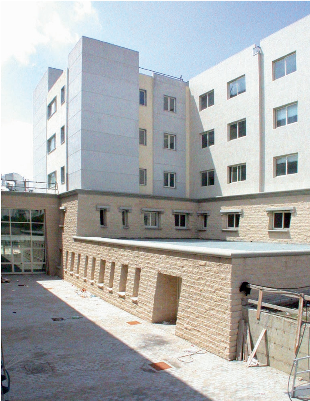
Public work P.O. SAN GIULIANO Giugliano in Campania (NA) 2002 - 2008
