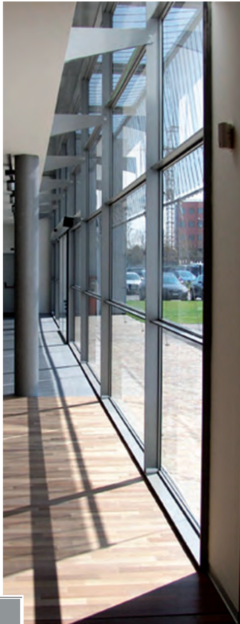
Porta automatica su facciata | Ponzi automatic door
