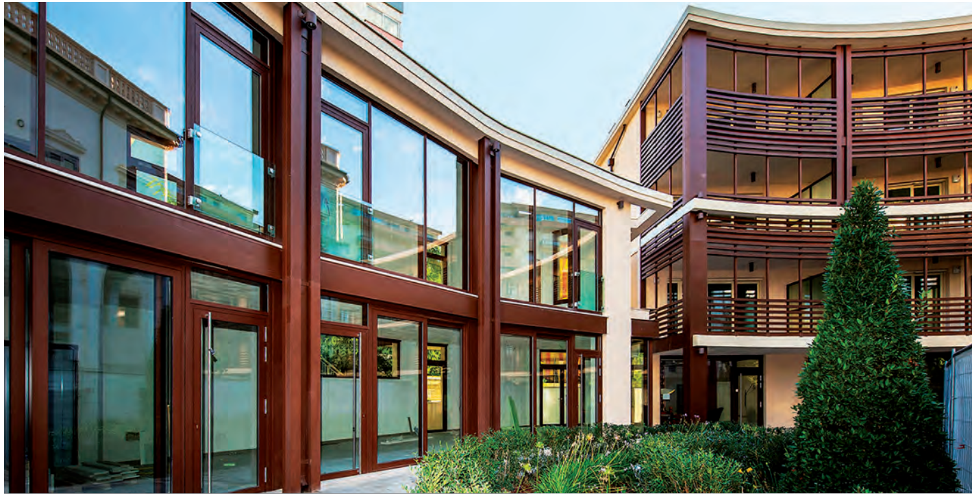
Vetrine e porte U.S. con rivestimenti in lamiera per complesso commerciale direzionale Glasses, frontshop aluminium cladding for a commercial real estate
