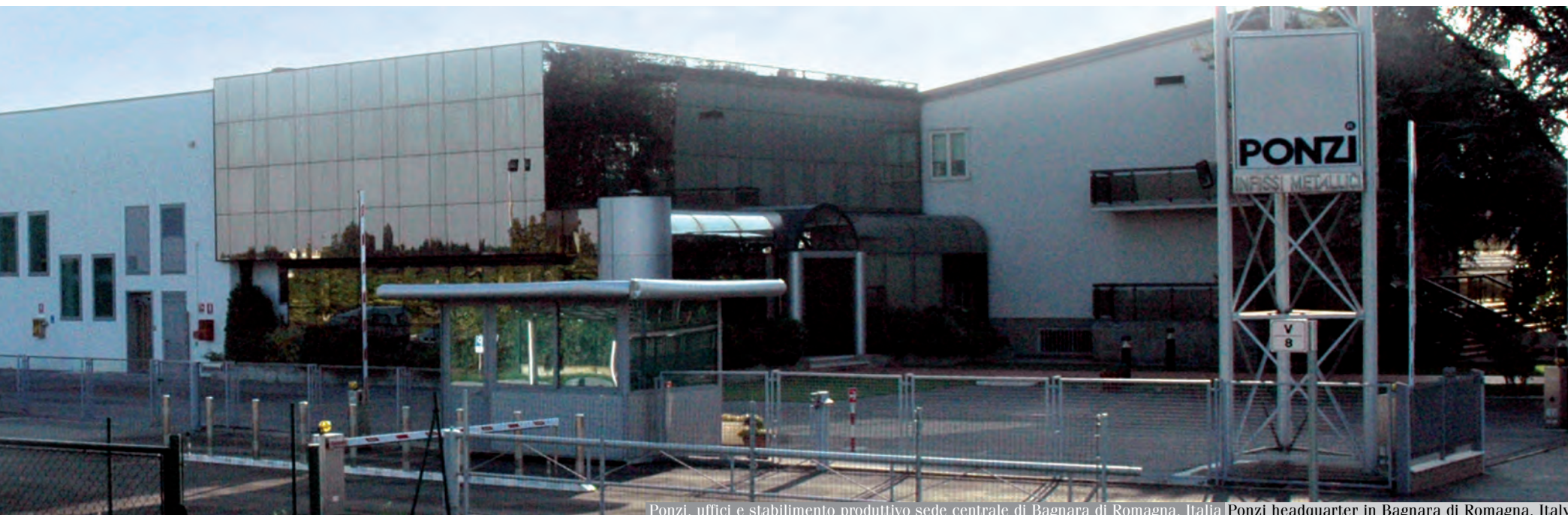
Ponzi, uffici e stabilimento produttivo sede centrale di Bagnara di Romagna, Italia Ponzi headquarter in Bagnara di Romagna, Italy
