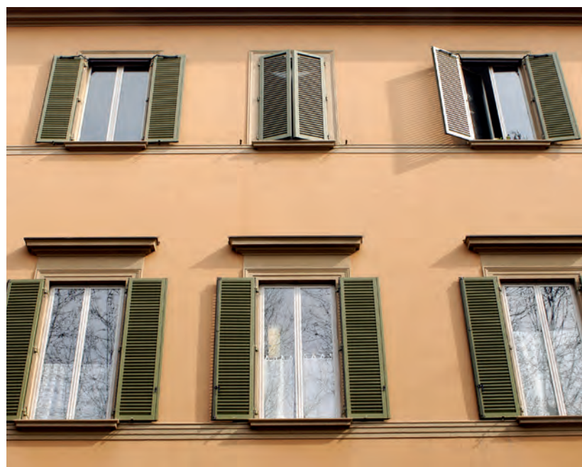
Finestre a battente alluminio-legno in centro storico | Alu-wood windows in historical centre
