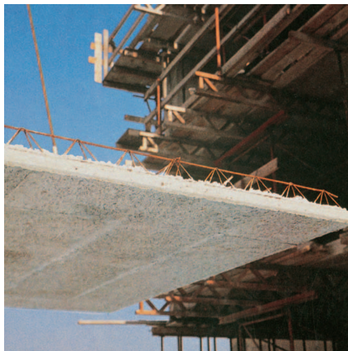
Solaio tipo predalles rivestito in fase di getto con pannelli Celenit.
