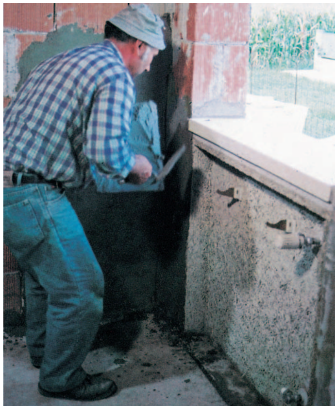
Il pannello Celenit P3, spessore 25 mm, posto ad isolare la nicchia radiatore fianchi e davanzale compresi, elimina il ponte termico e la sua finitura sarà quella della parete.
