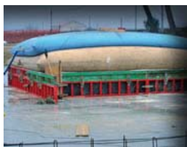
Prova di carico solaio prefabbricato
