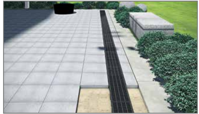
4 - Posare la pavimentazione.
