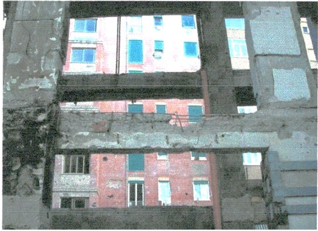
Fase: risanamento strutturale parti senza possibilità di ingresso adottata la tecnica del carbonio
