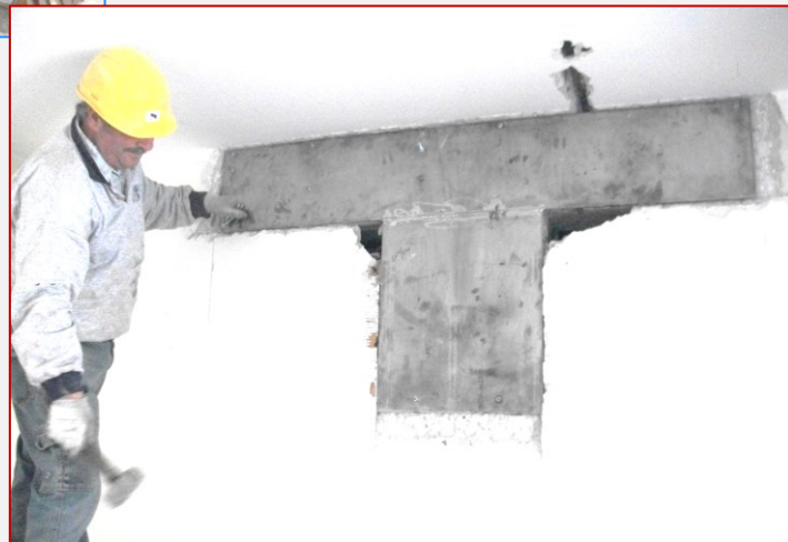
particolare del ripristino con piastre in acciaio inox
