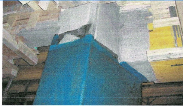
Fase: risanamento strutturale parti senza possibilità di ingresso adottata la tecnica del carbonio
