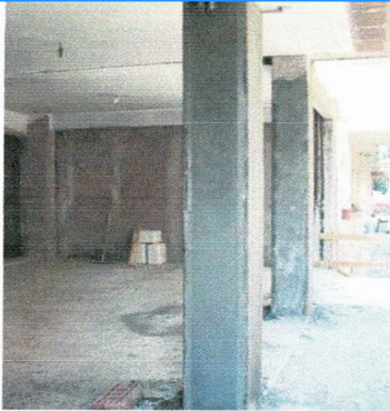
Fase: risanamento strutturale parti senza possibilità di ingresso adottata la tecnica del carbonio
