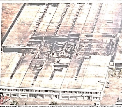
Area devastata una veduta aerea dell'area artigianale distrutta dall'incendio del luglio dello scorso anno.
