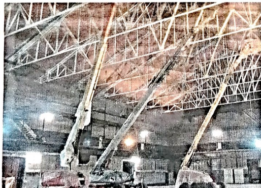
I lavori di ristrutturazione del teatro eseguiti dalla Saccomandi
