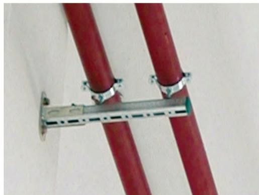
**Art. 82022** CorRail supporto longitudinale inclinabile completa di dadi scivolanti
