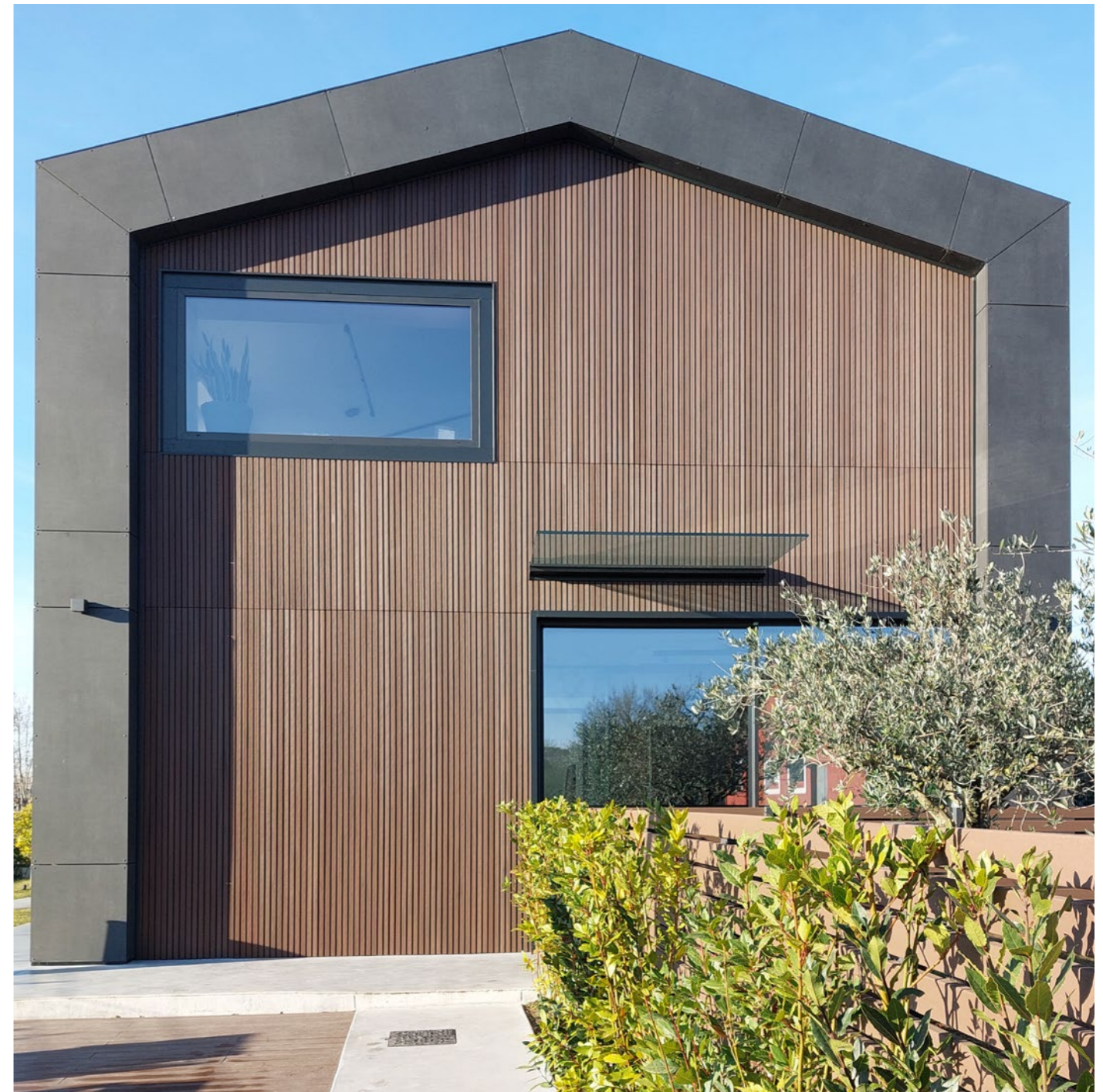
Edificio direzionale, Pomezia (RM)
